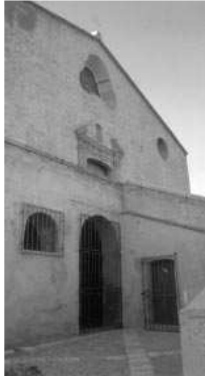
Grassano, chiesa di Sant'Innocenzo, ingresso. In basso sono collocati gli accessi agli ambienti del preesistente Palazzo della Commenda dei Cavalieri di Malta (Archivio fotografico ES-Progetti e Sistemi srl, Roma).
