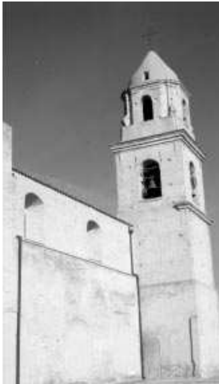
Grassano, chiesa di Sant'Innocenzo (campanile). L'edificio è costruito sui resti del Palazzo della Commenda dei Cavalieri di Malta (Archivio fotografico ES-Progetti e Sistemi srl, Roma).
