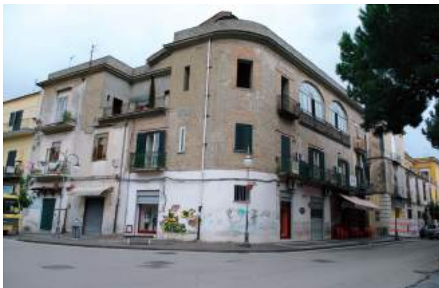
Fig. 15. Cicciano, il complesso da S-O. Nello spigolo, la torre angolare superstite.
