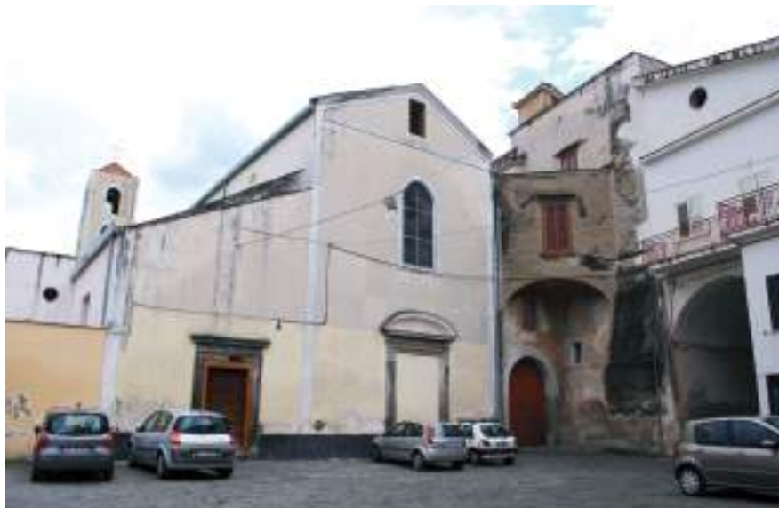
Fig. 20. Cicciano, il cortile del castro con la chiesa di S. Pietro. Sono visibili l'antico accesso murato e, al di sopra del portale dell'ex residenza dei commendatori, il passaggio pensile che conduceva al coretto, risultato dall'adattamento del gayfo medievale aderente alla "turris magna".
