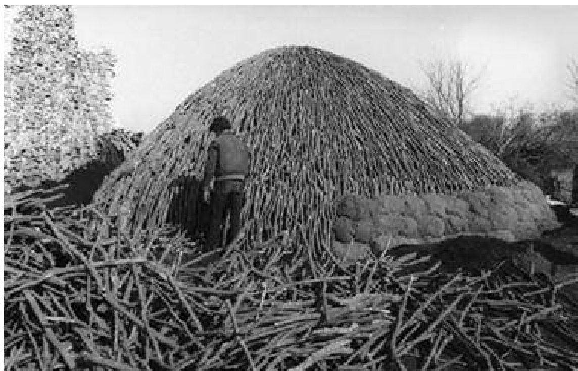
Fasi di produzione del carbone: preparazione della pira composta da 'tropelli' e la pira durante la combustione (da M. Tondi, La Scienza Silvana , Napoli 1810)
