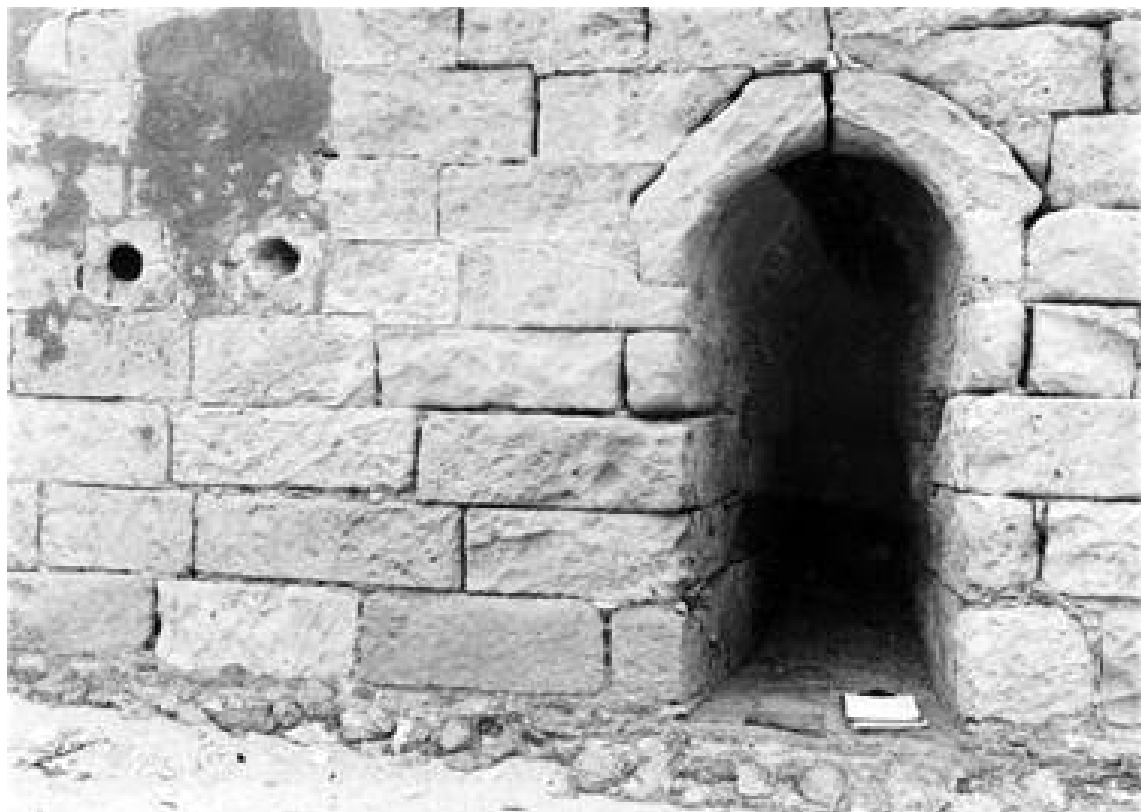
Briatico, Mulino della Rocchetta. Bocca d'alimentazione di un forno
