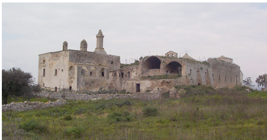
Fig. 11 – San Leonardo di Siponto, complesso conventuale (prima del restauro).
