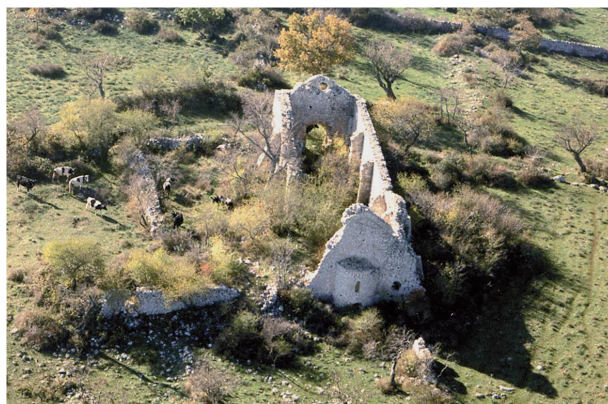
Fig. 4 – Sant'Egidio al Pantano, veduta aerea (Laboratorio Centro aerofotografico dell'Università degli Studi di Bari, 1989).
