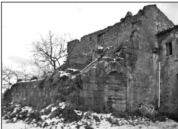
In alto: una foto del secolo scorso (da www.valentano.org ); sopra: una foto di pochi anni fa (© A. Ceccarelli), in cui è visibile il degrado a cui è stata sottoposta la chiesa nel corso del tempo.
