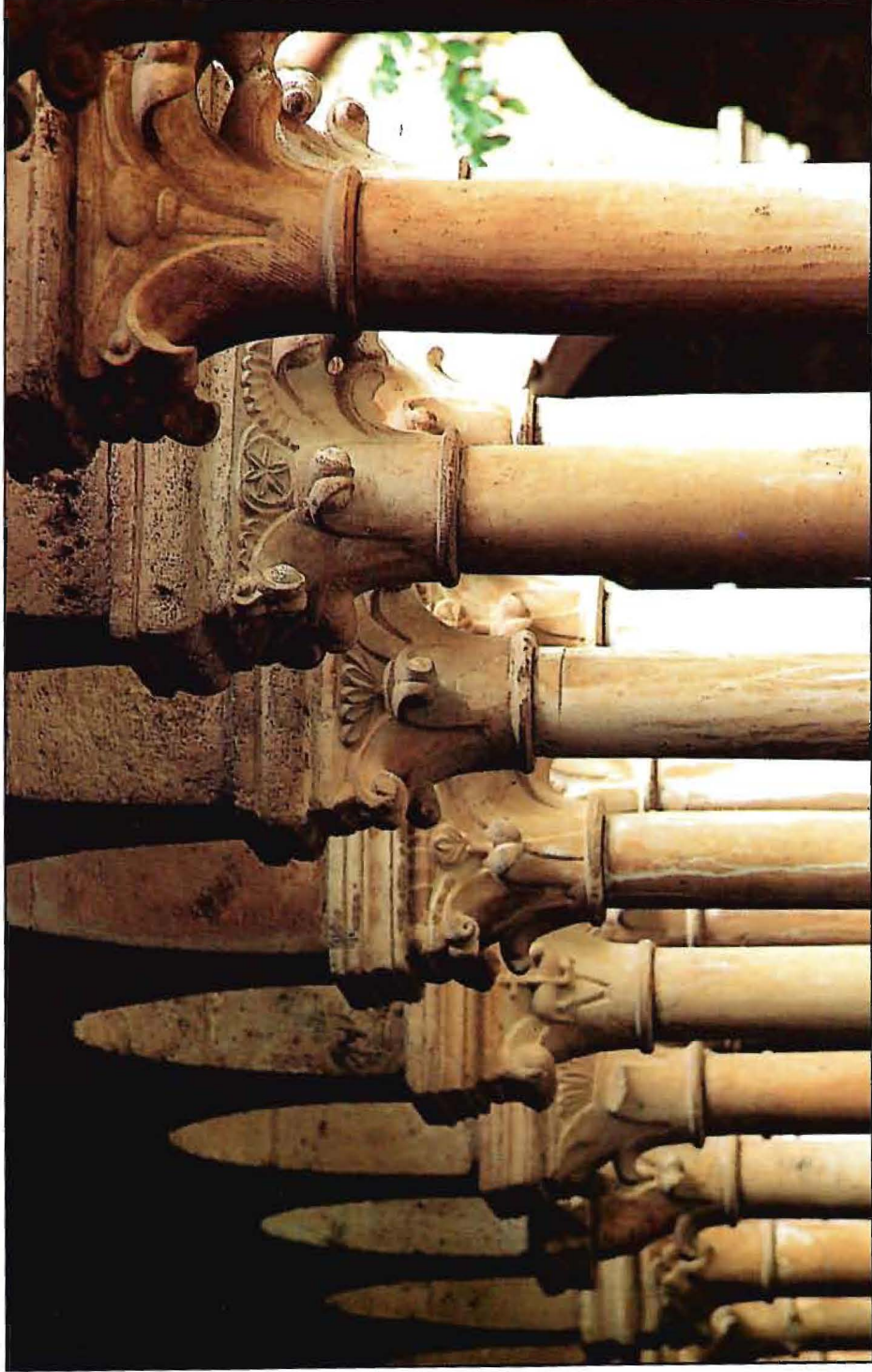
Particolare del lato nord del chiostro
